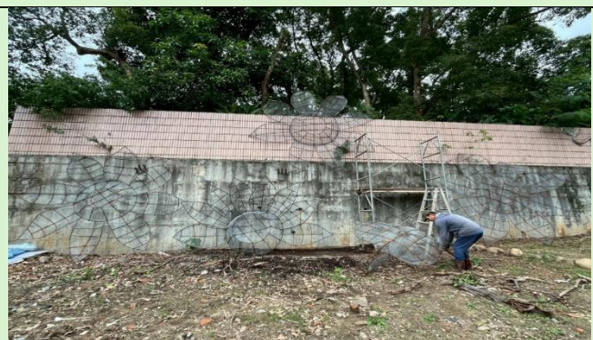
現場鋼筋組裝骨架
