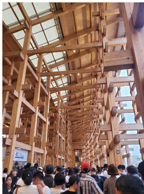
圖3 大屋根建築結構現代建造傳統結構施作 資料來源：筆者提供
